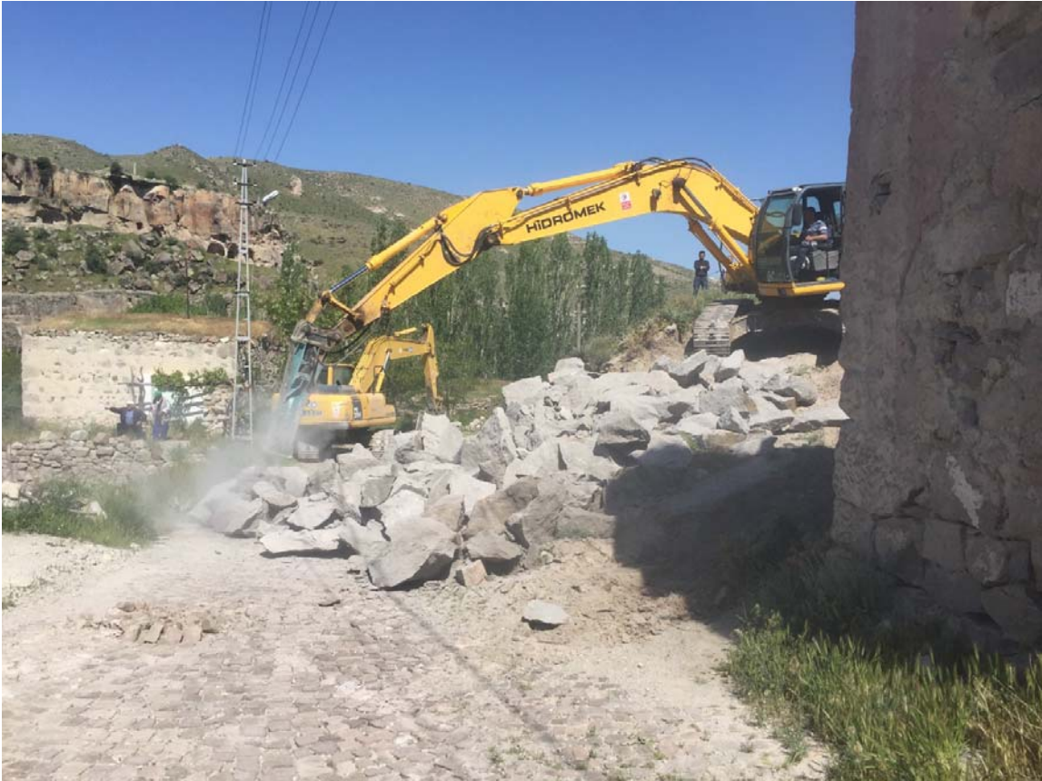
Belısırma Köyü kaya düşmesi sonucu yapılan çalışmalar
